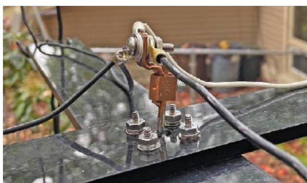
Fot. 1.2.7.5. Podłączenie górnych ramion dipoli do przedłużonego środkowego kontaktu gniazdka przy użyciu metalowego zacisku
